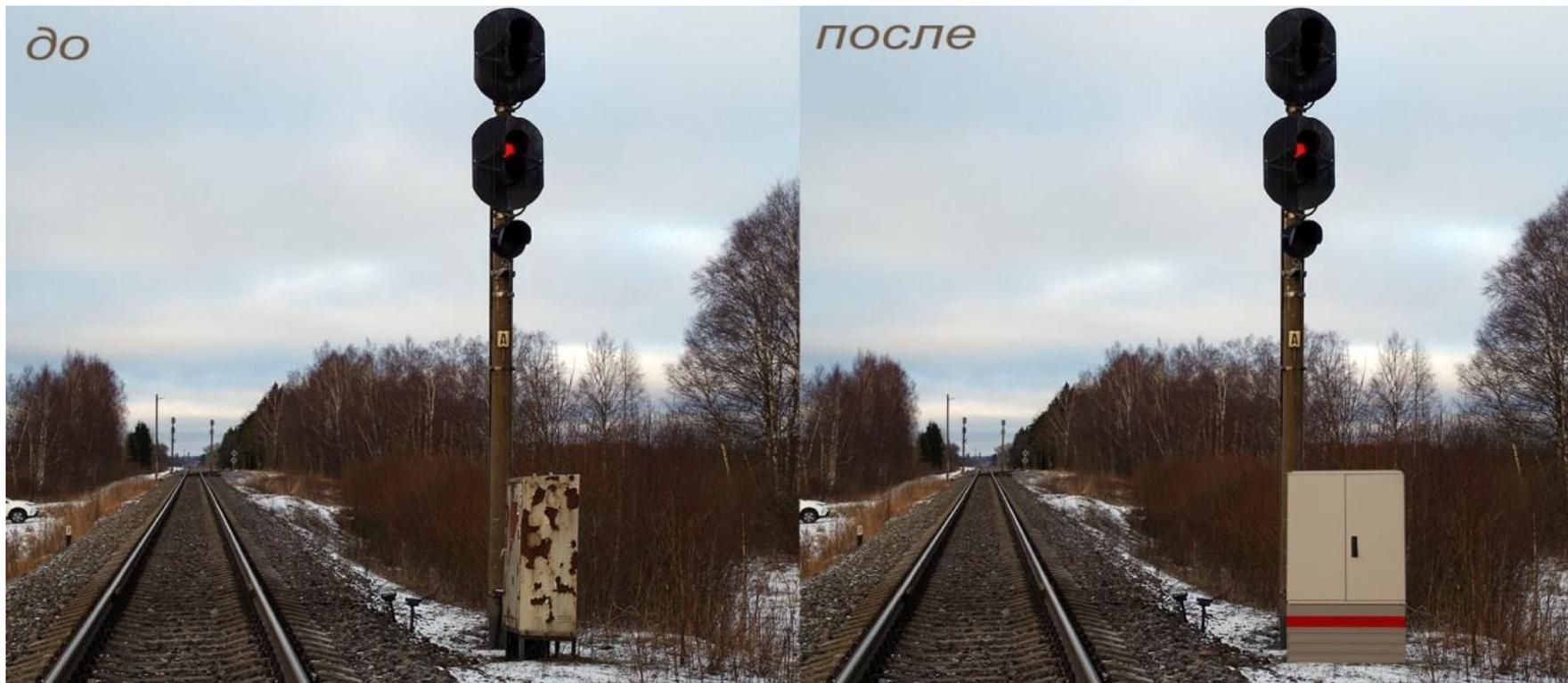
Пример установки шкафа универсального для РЖД в Тульской области. Предлагаемый шкаф имеет тот же полезный объем, что и ныне применяемые шкафы ШРУ-М. Но обладает рядом преимуществ, позволяющих безопасно эксплуатировать установленное внутри оборудование в трое дольше.
