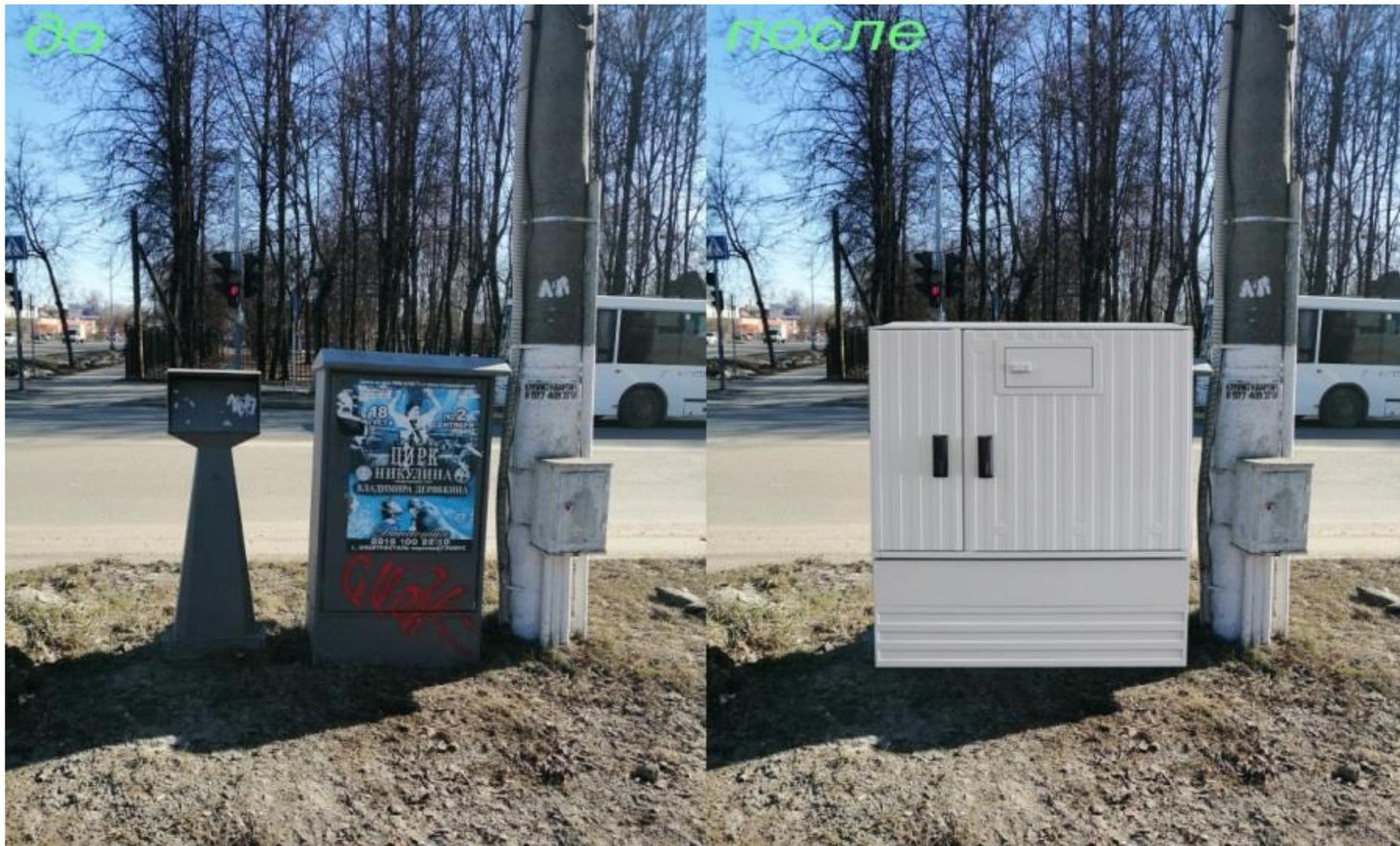
Пример шкафа управления дорожным движением в городе Электросталь, Московская область. Выносной пульт управления интегрирован в общий шкаф и, для разделения доступа к оборудованию, установлен за отдельной дверцей.
