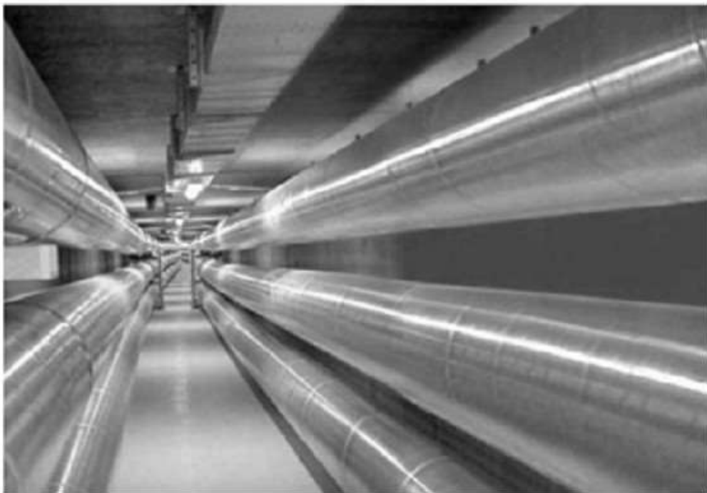
Рис. 6 ГИЛ в тоннеле.
