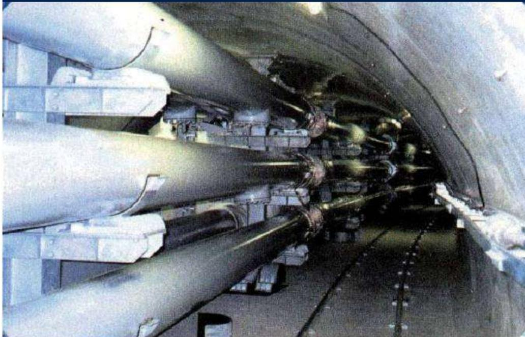
Японской фирмой Chubu Electric Power Co была введена в эксплуатацию одна из первых газоизолированных линий второго поколения (рис. 4), заполненная смесью из элегаза и азота. В рамках этого проекта были проведены работы по замене существующей воздушной линии 275 кВ на ЛГИ в туннеле, что позволило получить дополнительные городские площади.
