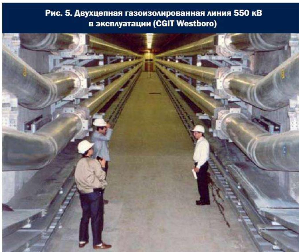
Прежде всего газоизолированные линии применяются там, где на подстанциях требуется повышенная безопасность. В этом случае ошиновка осуществляется с помощью ЛГИ. При пересечении нескольких линий электропередачи также оптимальным является применение газоизолированных линий.
