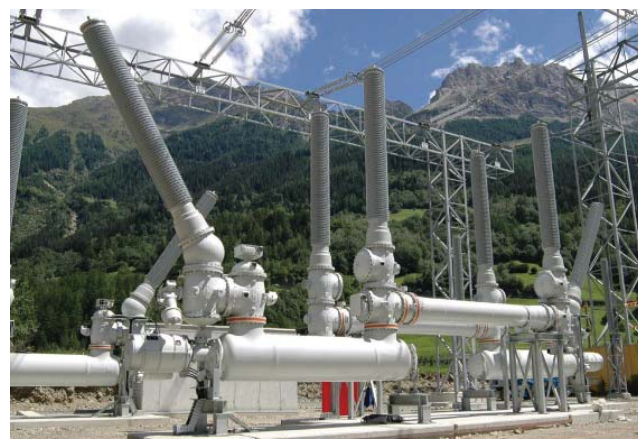
Рис. 10. Гибридные коммутационные аппараты на 145 кВ и РУ-420 кВ на базе гибридных аппаратов
