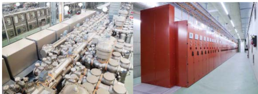
Рис. 8. Газонаполненные КРУ различного исполнения на напряжение 170 кВ и 24 кВ с использованием высокопрочного газа на основе смеси кетонов
