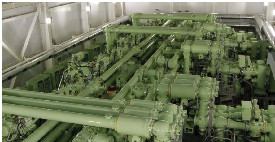
Рис. 1. КРУЭ 220 кВ на подстанции «Койсуг»
